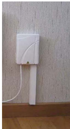
Skarvbox – Inomhusmonterad Mått: HxBxD 11 x 9 x 2 (cm)
