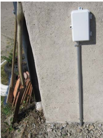
Skarvbox – Utomhusmonterad Mått: HxBxD 21 x 14 x 4 (cm)
